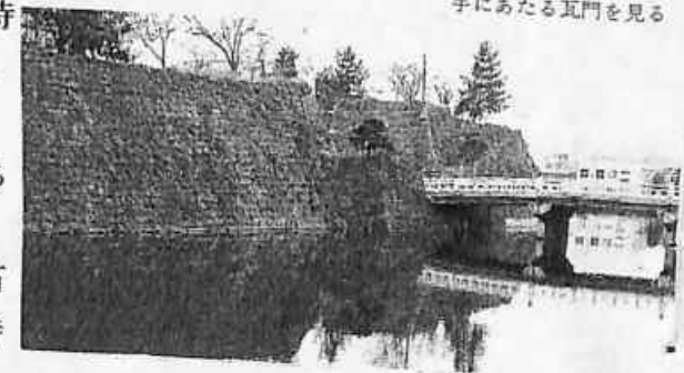
福井城本丸南面 本丸大手にあたる瓦門を見る
